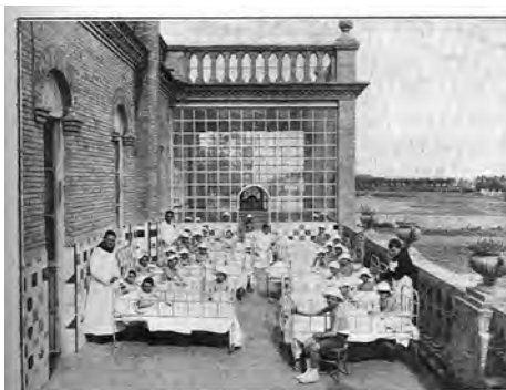
Galería de sol de los encamados, cubierta y descubierta
